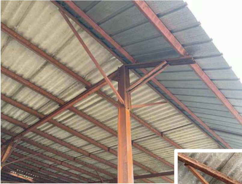
Détail attache type existante nef 01 / 02
