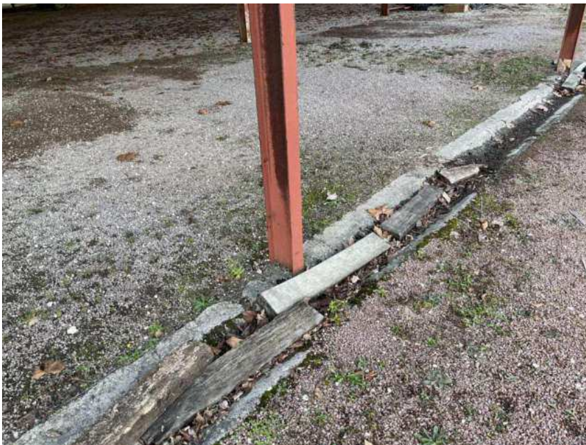
Pied de poteau Nef 01
