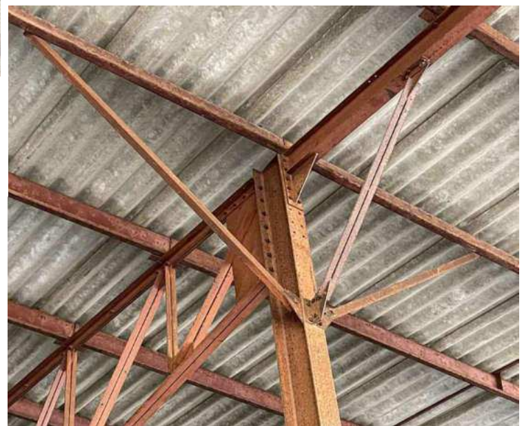
Détail attache type existante nef 01 / 02
